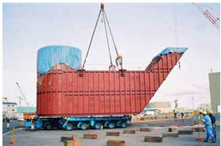
図 2.1.7 原子炉下部キャビティ室構造体
