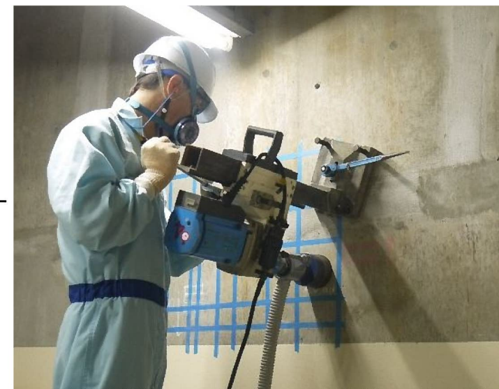
コンクリートサンプル採取状況
